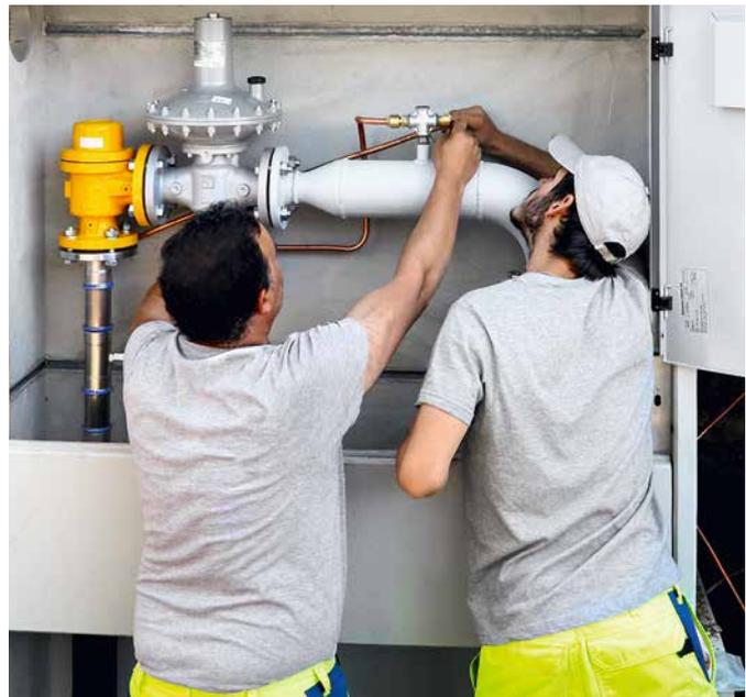
Rénovation d'un poste de détente à Penthaz, sur le réseau de Cosvegaz SA.
